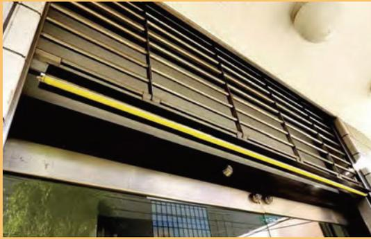
长度不受限制的带状感压开关，用指尖轻轻按压任何部位均可操作ON/OFF。
